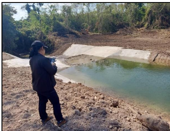
รูปภาพที่ ๑-๓ อาคารดักตะกอนดินแบบคอนกรีต (ขนาดความกว้าง ๗ เมตร สูง ๒ เมตร)
