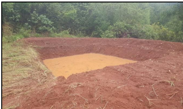
รูปภาพที่ ๑-๙ บ่อดักตะกอนดิน
