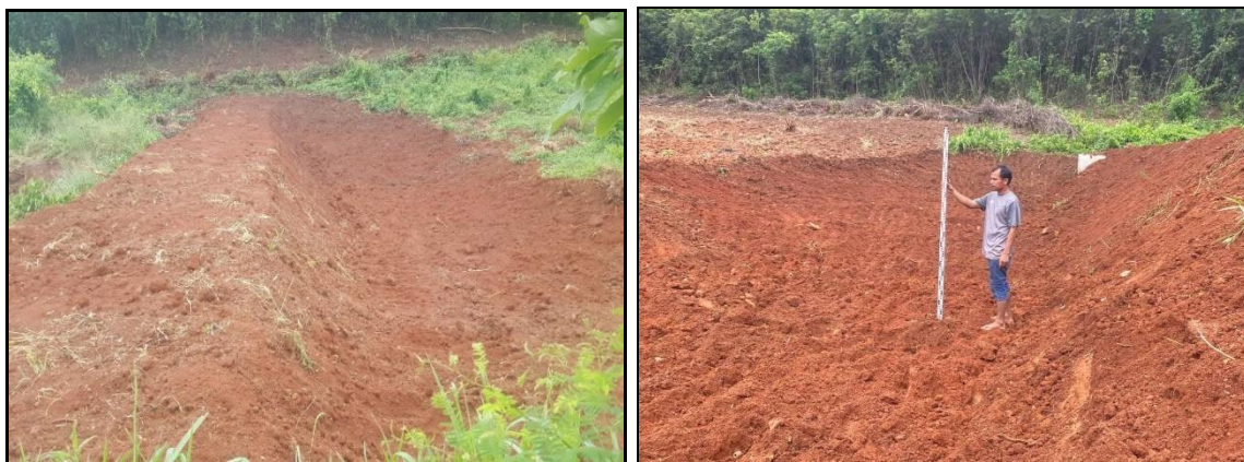
รูปภาพที่ ๑-๖ บ่อดักตะกอนดิน(รูปแบบคันดินดักตะกอน)
