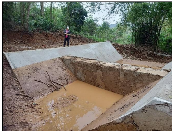
รูปภาพที่ ๑-๓ อาคารดักตะกอนดินแบบคอนกรีต (ขนาดความกว้าง ๗ เมตร สูง ๒ เมตร)
