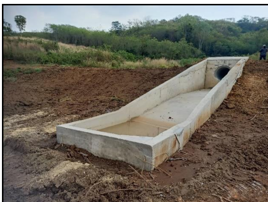
รูปภาพที่ ๑-๕ อาคารท่อระบายน้ำ ขนาด \varnothing ๐.๘ เมตร
