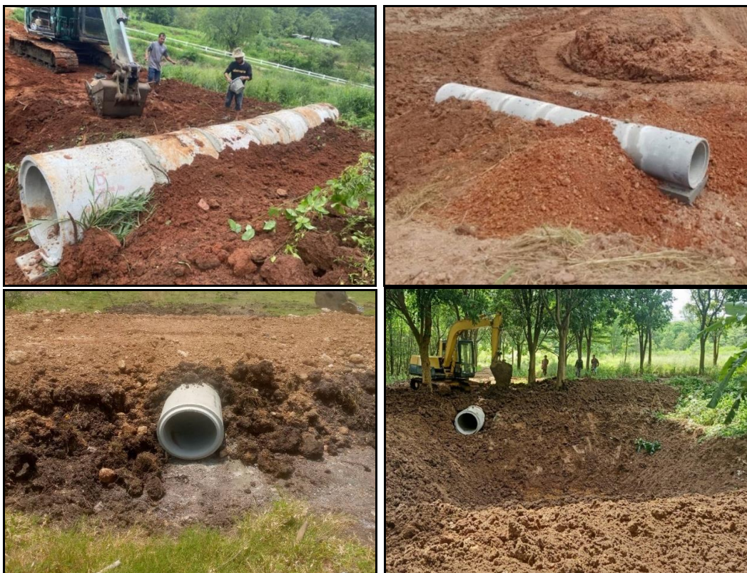
รูปภาพที่ ๑-๗ ท่อระบายน้ำ (ค.ส.ล.) ขนาด \varnothing ๐.๓๐ ขนาด \varnothing ๐.๖๐ และ ขนาด \varnothing ๐.๘๐ เมตร
